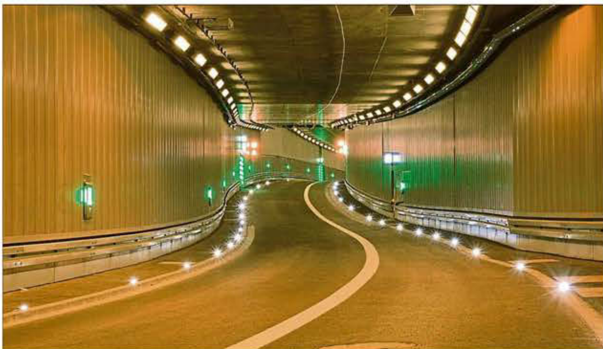
Luise-Kiesselbach- und Heckenstallertunnel: Nach dem Petuel- und Richard-Strauss-Tunnel die dritte große Baumaßnahme im Zuge der Untertunnelung des Mittleren Rings. FOTO OBERMEYER
