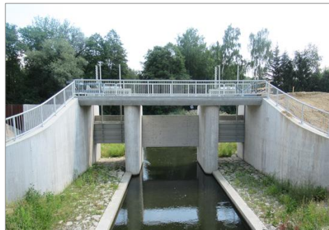
Drosselbauwerk Mindel, Ansicht unterstrom.
