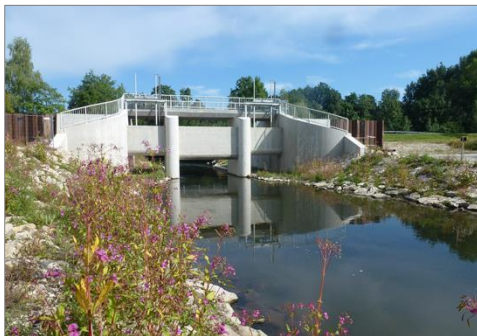
Drosselbauwerk Mindel, Ansicht oberstrom.
