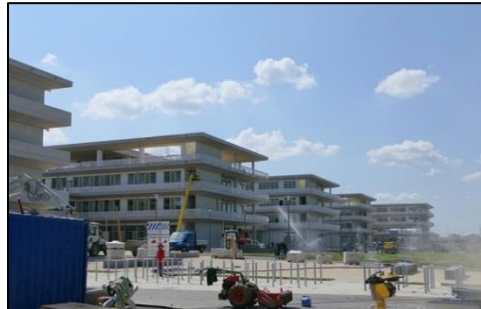
Letzte Baumaßnahmen wenige Wochen vor Inbetriebnahme.
