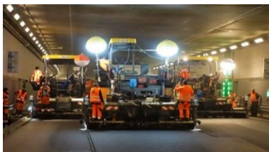
Die Fahrbahnen im Tunnel werden asphaltiert.
