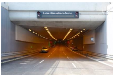
Einfahrt in den Tunnel
