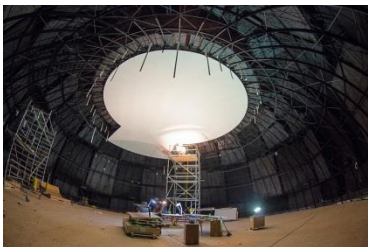
Die Kuppel des Planetariumssaals während der Bauphase (nach Montage der Akustikpaneele)
