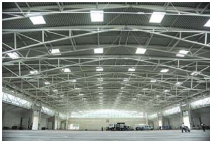
1 Blick in die im Bau befindliche Halle C5.
