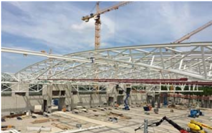
3 Einhub der Fachwerkbinder im Mai 2017.
