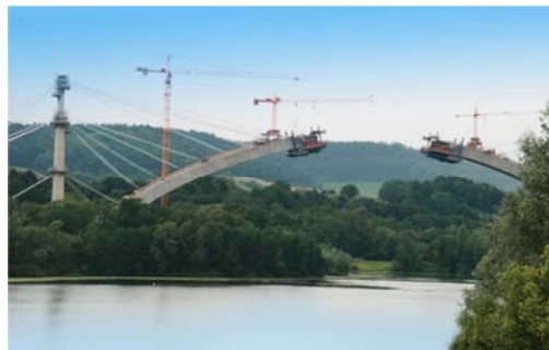
Brücke Froschgrundsee im Bau (© OBERMEYER)
