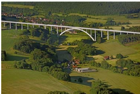
Grümpentalbrücke (© Nürnberg Luftbild, Hajo Dietz)
