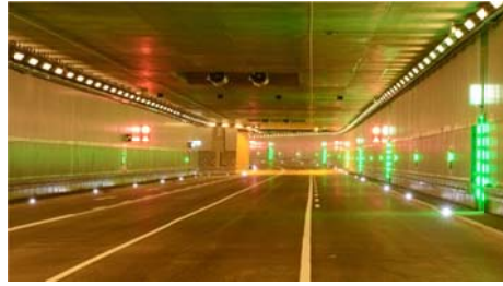
241.000 m 3 Beton und 31.000 t Bewehrungsstahl waren für die beiden Tunnelröhren nötig. © OBERMEYER
