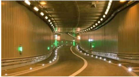
Luise-Kiesselbach- und Heckstallertunnel: nach dem Petuel- und Richard-Strauss-Tunnel die dritte große Baumaßnahme im Zuge der Untertunnelung des Mittleren Rings. © OBERMEYER
