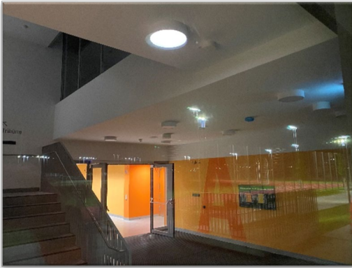
Alle Zugangstüren sind mit Handtastern oder Deckensensoren ausgestattet und öffnen sich dadurch ohne Kraftaufwand.
