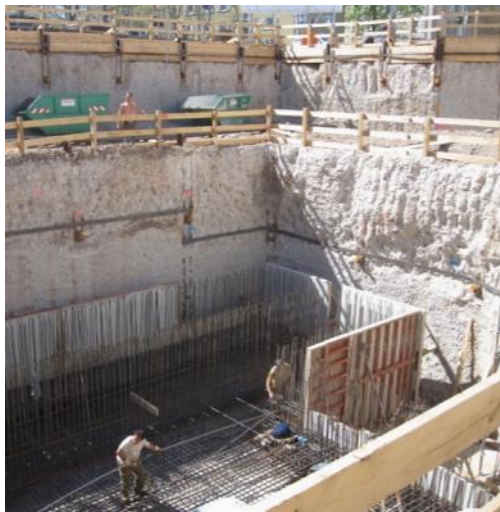
Kaltwasserspeicher im Bau
