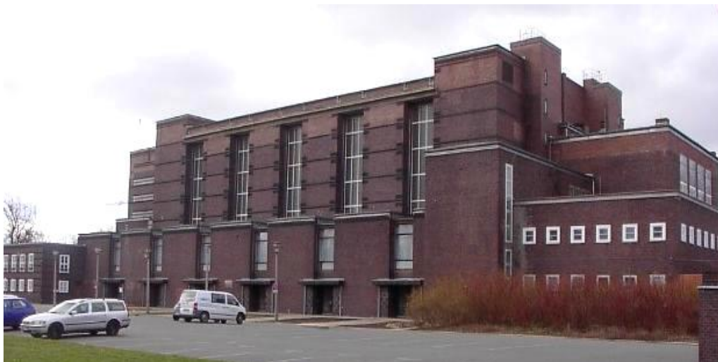
Bestandsgebäude Stadthalle Magdeburg
