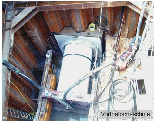
Startbaugrube (Schacht 3)
