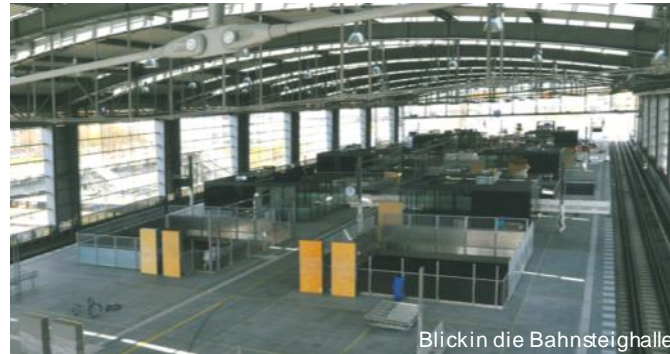
Blick in die Bahnsteighalle
