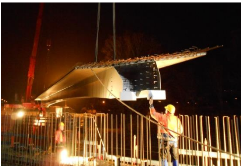
Herstellung Überbau für 1. Teilbauwerk
