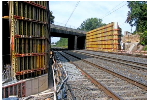
Herstellung Unterbauten für 1. Teilbauwerk
